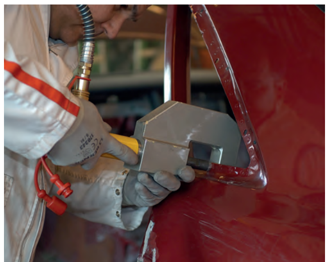
En las carrocerías de aluminio se utiliza frecuentemente el remache junto con adhesivo.
